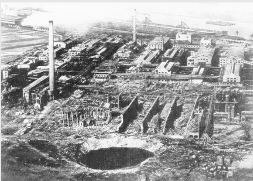
Destruction d'Oppau en 1921 par l'explosion d'un mélange de sulfate d'ammonium et de nitrate d'ammonium.
